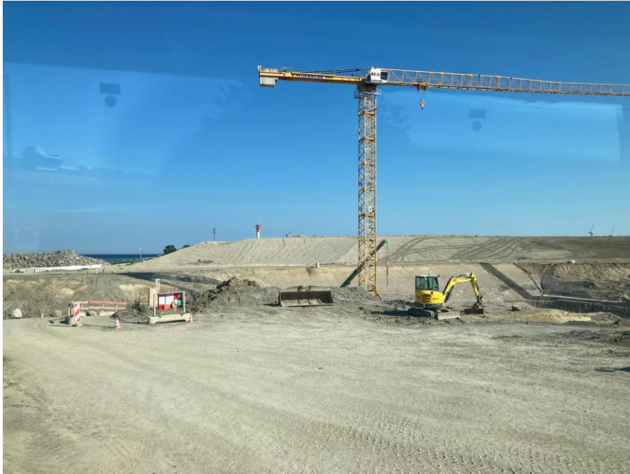
Ein Eindruck: Weitläufigkeit der Baustelle.
